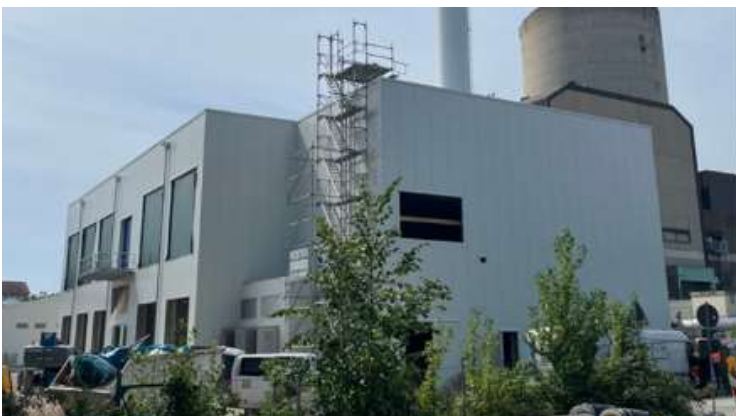
Abbildung 48: Hochflexibles Biomethan-Blockheizkraftwerk in Hannover-Herrenhausen
