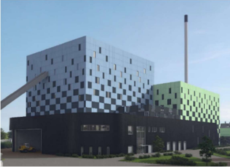
Abbildung 47: Biomasseheizkraftwerk in Hannover-Stöcken (nach Fertigstellung)
