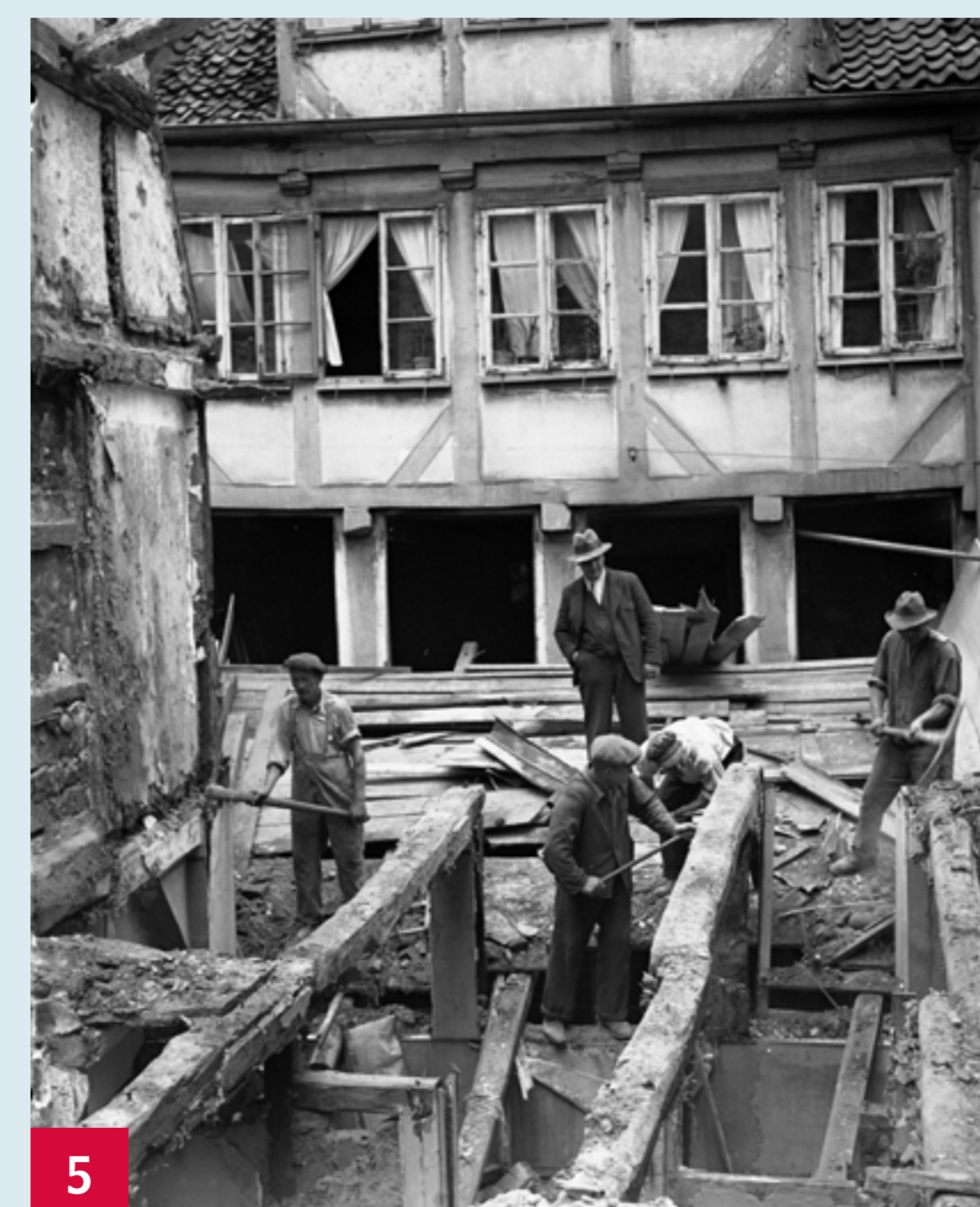
5 Abbruch und Sanierung in der Ballhofstraße, Juli 1936. Foto von Wilhelm Hauschild
