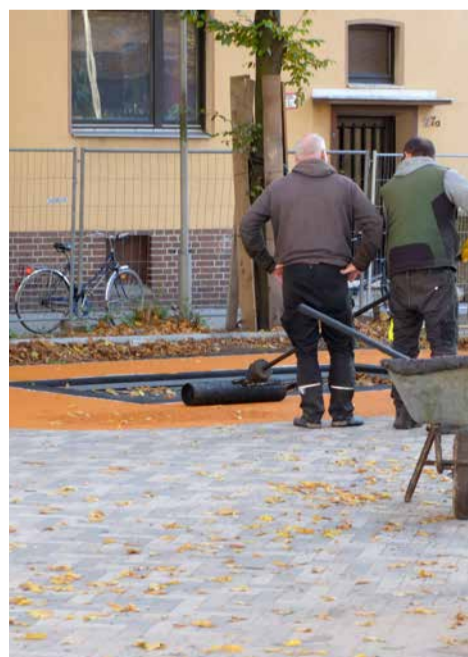
Mit einer Walze wird der Fallschutzbelag befestigt.
