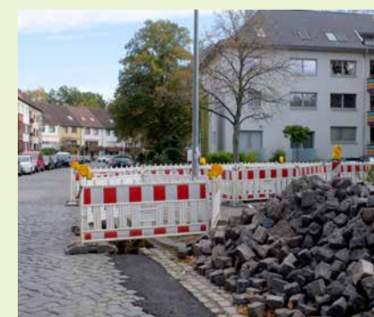
Die Umgestaltung soll bis Oktober 2022 abgeschlossen sein.
