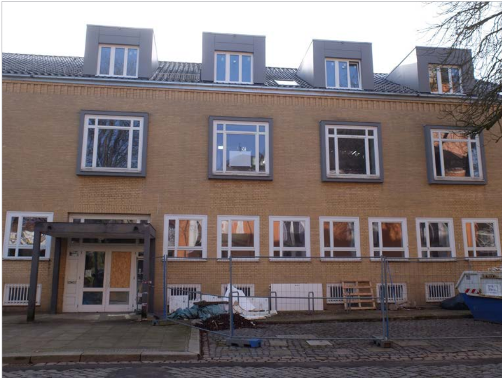
Die Arbeiten am ehemaligen Gemeindehaus in der Turmstraße kommen gut voran. (LHH)
