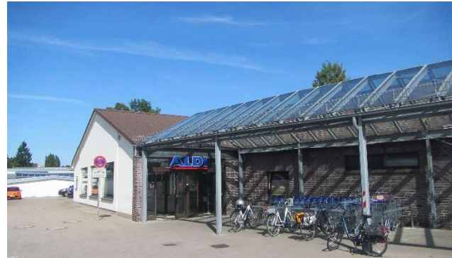
Abb. 230: Eindrücke aus dem D-Zentrum Oberricklingen Göttinger Chaussee
