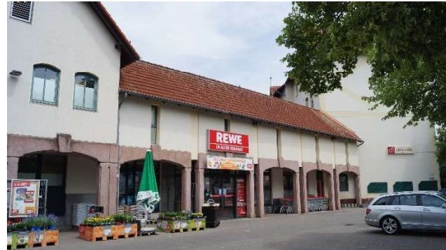
Abb. 150: Eindrücke aus dem E-Zentrum Misburg-Nord Hannoversche Straße
