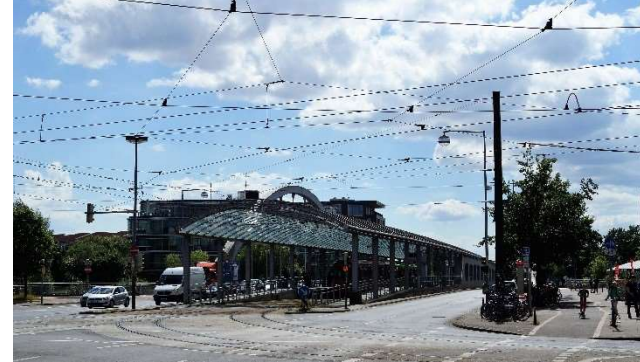
Abb. 94: Eindrücke aus dem C-Zentrum Bothfeld Sutelstraße
