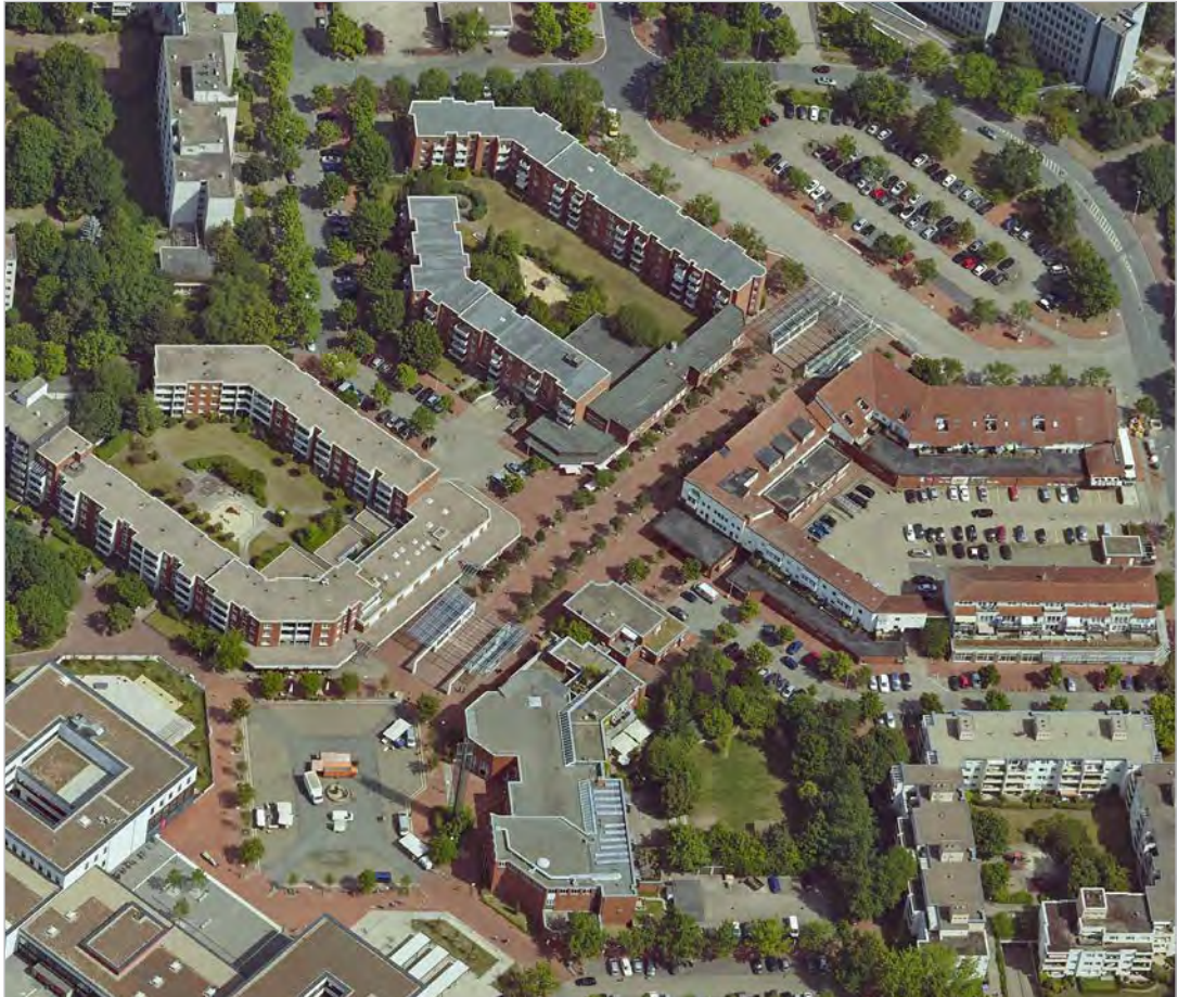
Schrägluftbild Mühlenberg Zentrum (LHH, Bereich Geoinformation)
