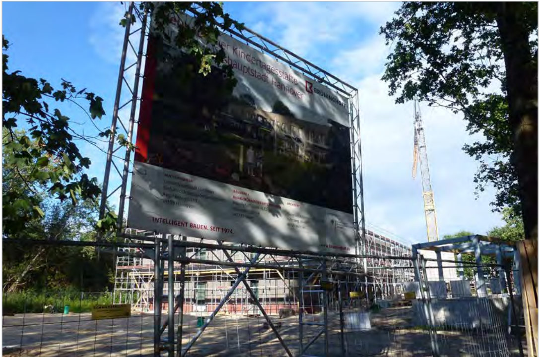
Baustelle Familienzentrum Beckstraße (LHH)
