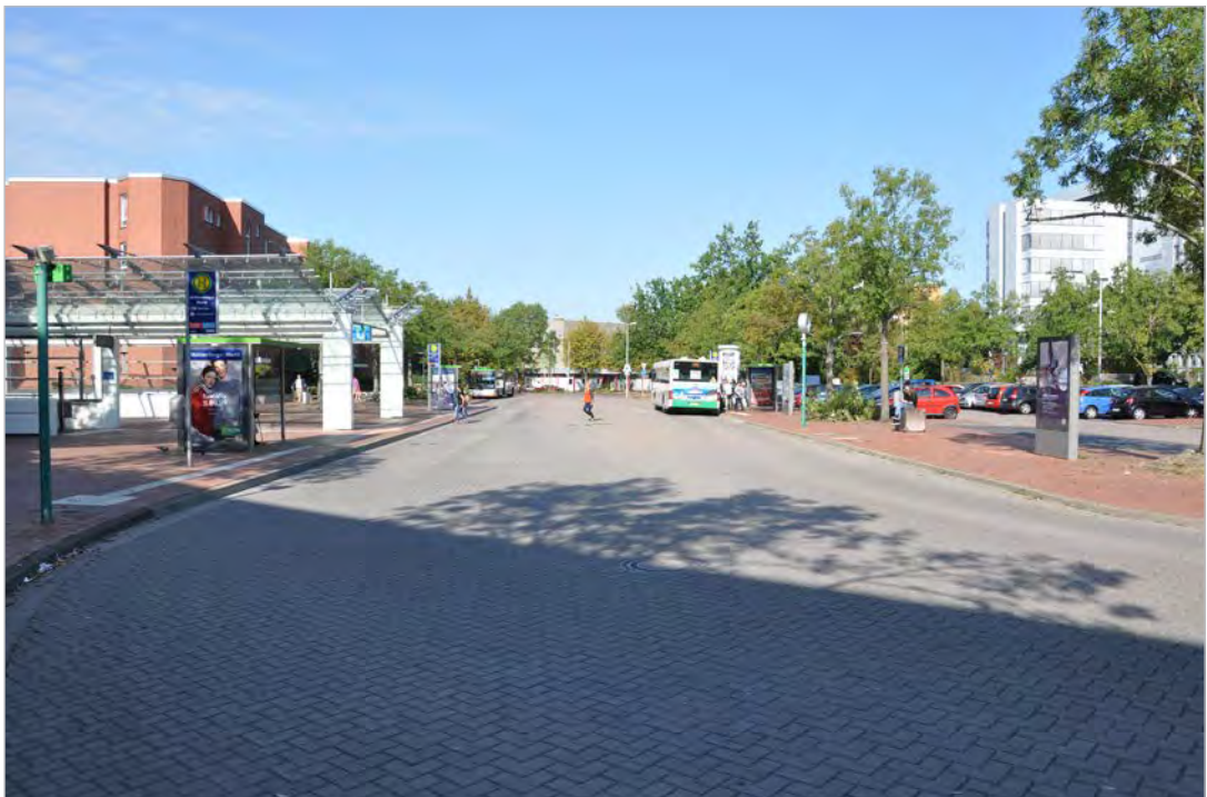
Breite Bus-Umsteigeanlage ohne barrierefreie Querung (Büro Christine Früh)
