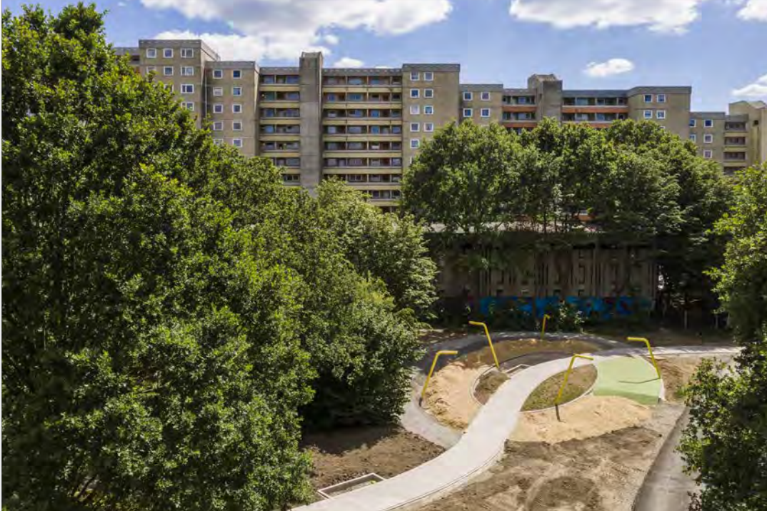
Spielplatz und erster BA Grünverbindung Canarisweg im Bau (Helge Krückeberg)
