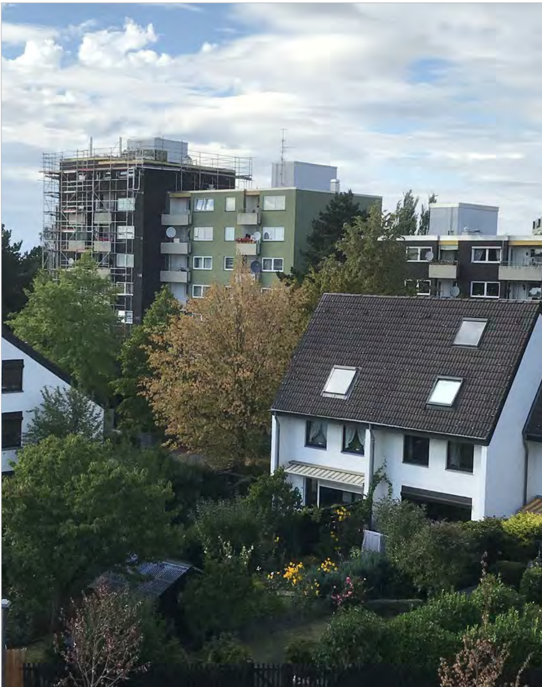
Mehrfamilien- und Reihenhäuser Mühlenberg (LHH)
