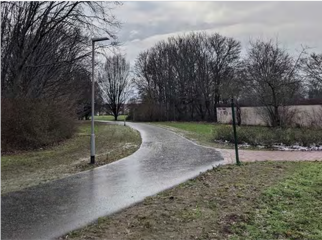
Umsetzung der Beleuchtung im Manele-Süß-Weg (LHH)
