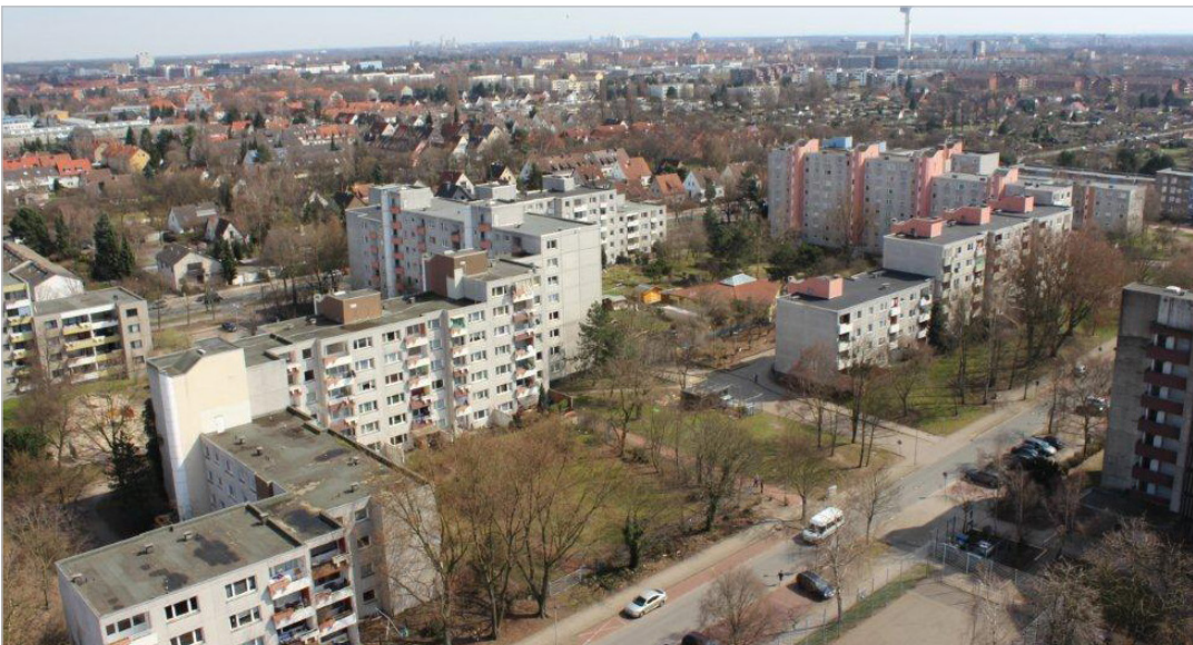
Blick auf den Bestand der Deutsche Wohnen vor der Sanierung (LHH)
