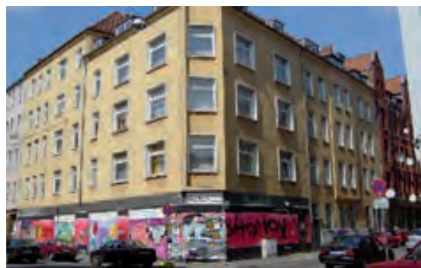
SCHAUFELDER STRASSE 8-9: VOR MODERNISIERUNG
