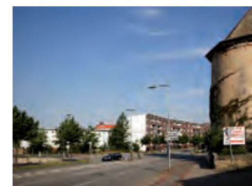
WEIDENDAMM NACH VERLÄNGERUNG
