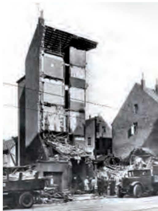
RÄUMUNG EINES TRÜMMERGRUNDSTÜCKS AM ENGELBOSTELER DAMM
