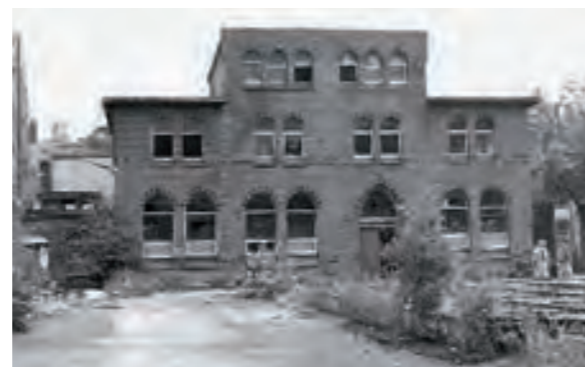
SPRENGEGELÄNDE: EHEMALIGE TURNHALLE
