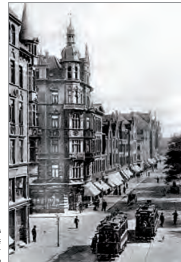
HISTORISCHE BEBAUUNG AN DER CHRISTUSKIRCHE BLICK ÜBER DEN KLAGESMARKT NACH SÜDEN
