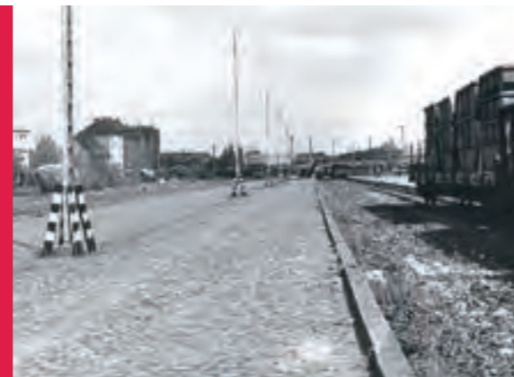
MÖHRINGSBERG: ALTE LADESTRASSE
