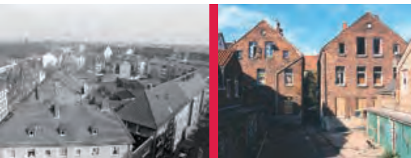
HEISEHOF: BLICK AUF GEWERBE IM BLOCKINNENBEREICH HEISENSTRASSE 6 UND 6A
