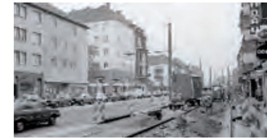
ENGELBOSTELER DAMM: WÄHREND DES UMBAUS WAR DIE SITUATION FÜR DIE EINZELHÄNDLER OFT SCHWIERIG.
