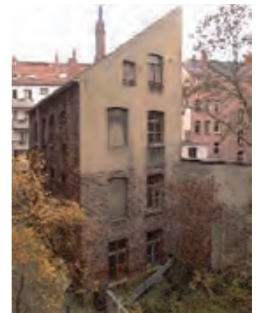
ORDNUNGSMASSNAHME AUF PRIVATGRUNDSTÜCK: HINTERHAUS VOR DEM ABRUCH
