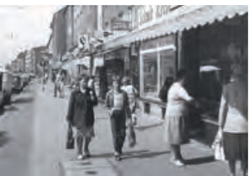
ENGELBOSTELER DAMM VOR UMBAU
