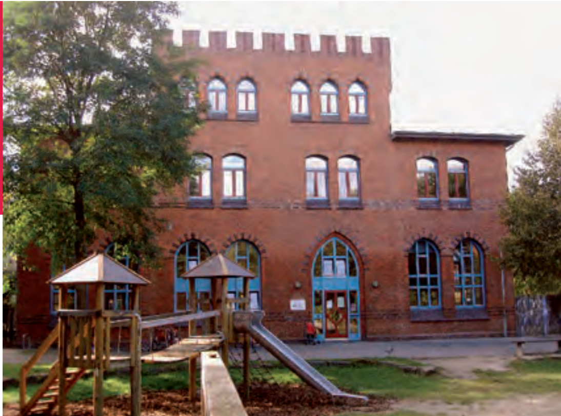
SPRENGEGELÄNDE: KINDERTAGESSTÄTTE IN DER UMGEBAUTEN TURNHALLE
