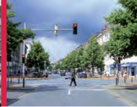
ENGELBOSTELER DAMM: NACH DER UMGESTALTUNG DER STRASSE
