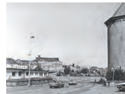
WEIDENDAMM VOR VERLÄNGERUNG
