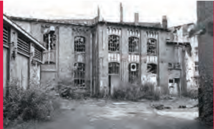
SPRENGEGELÄNDE: EHEMALIGES MASCHINENHAUS
