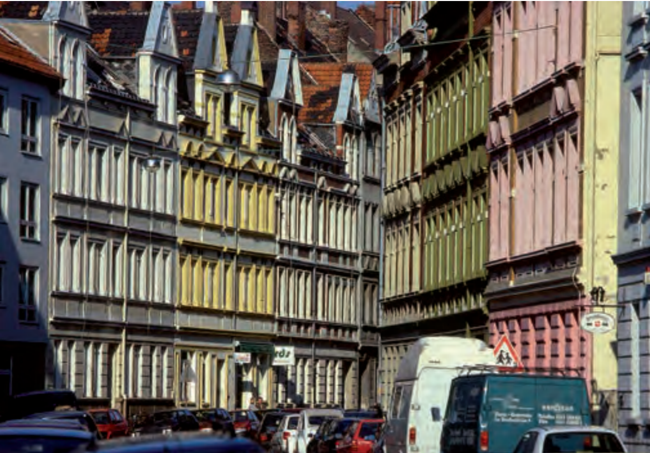
HAHNENSTRASSE: MODERNISIERTE ALTBAUTEN
