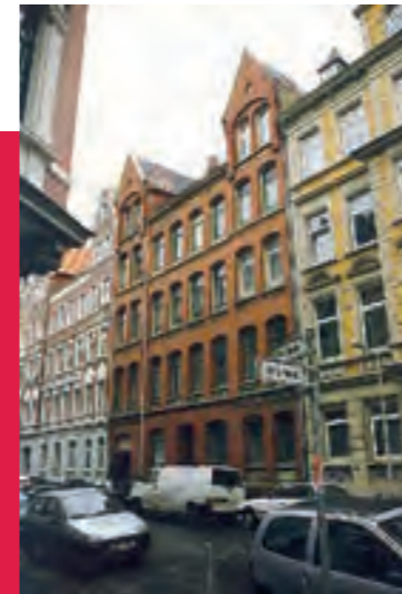
FLIEDERSTRASSE 1: VOR DER MODERNISIERUNG
