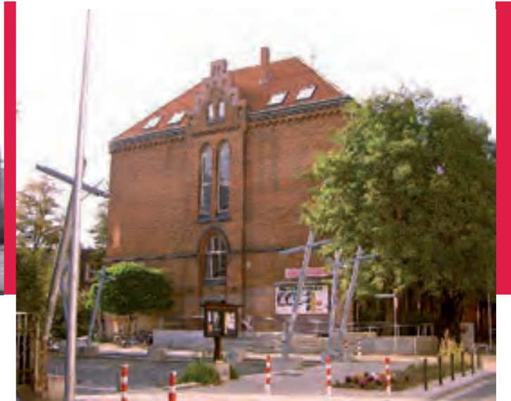
STADTTEILZENTRUM BÜRGERSCHULE NACH MODERNISIERUNG
