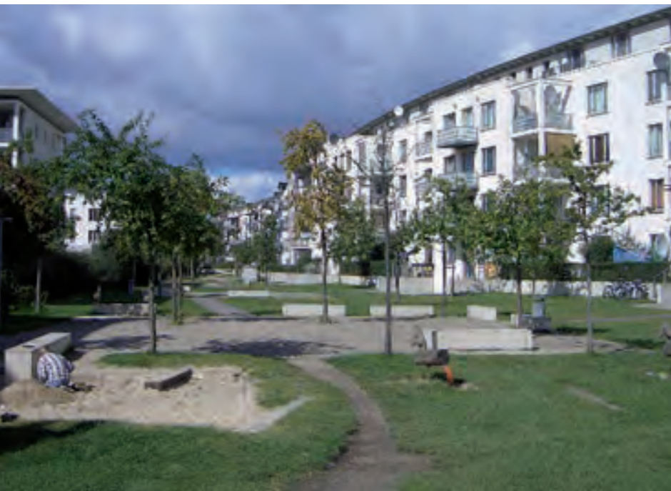
MÖHRINGSBERG: WOHNBEBAUUNG INNENBEREICH
