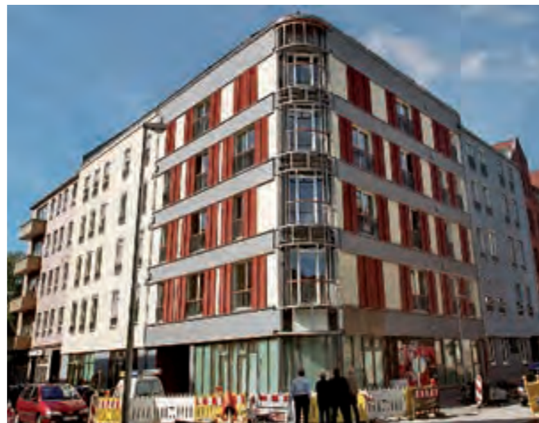
SCHAUFELDER STRASSE 8-9: NACH MODERNISIERUNG MIT PASSIVHAUSSTANDARD
