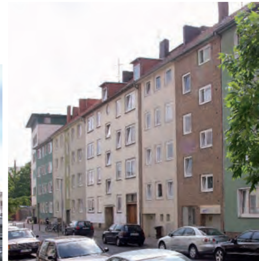
SCHEFFELSTRASSE: NEUBEBAUUNG AUS DEN 50ER JAHREN IM ÖSTLICHEN TEIL DER NORDSTADT
