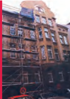
AM KLEINEN FELDE 26: VOR MODERNISIERUNG
