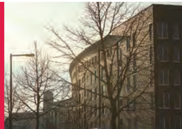
MÖHRINGSBERG: „WOHNSCHLANGE“, ANSICHT WEIDENDAMM
