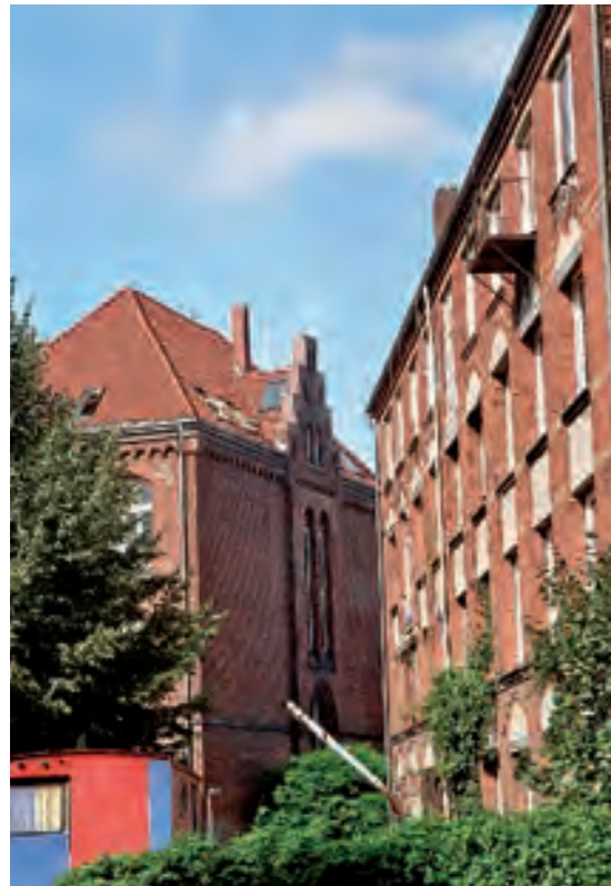
SPRENGELGELÄNDE: BLICK ENTLANG DER KOFFERFABRIK ZUR BÜRGERSCHULE
