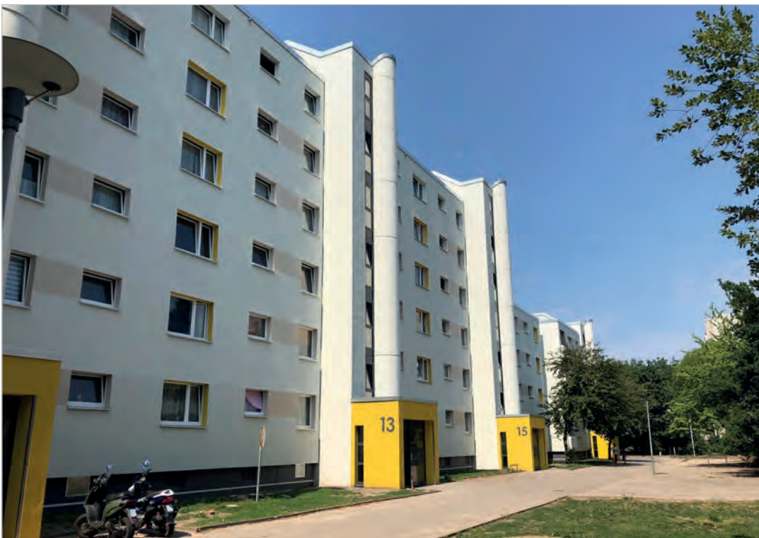
Modernisierung des Wohnbestandes im Spessartweg (Jendrik Kruse)
