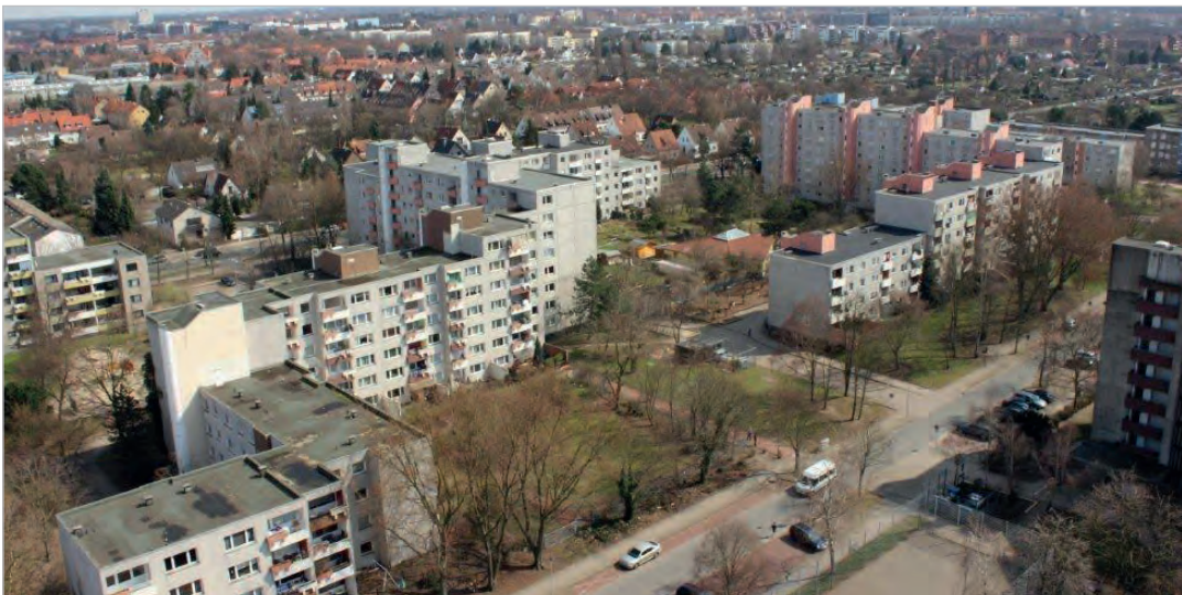
Blick auf den Bestand der Deutsche Wohnen vor der Sanierung (LHH)
