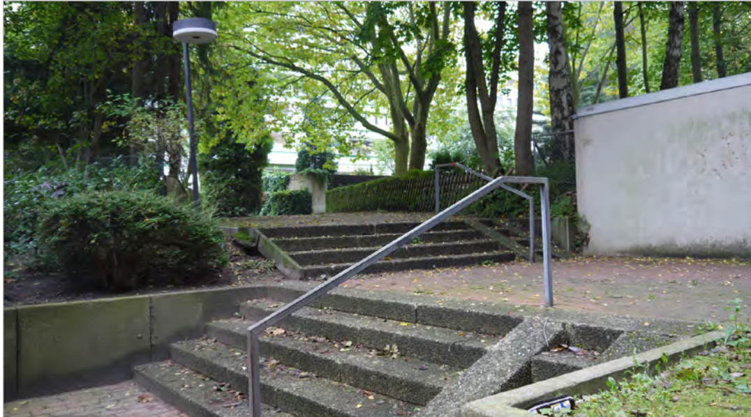
Fußweg zu Bonhoefferstraße mit schwer überwindbarer Stufenanlage (LHH)
