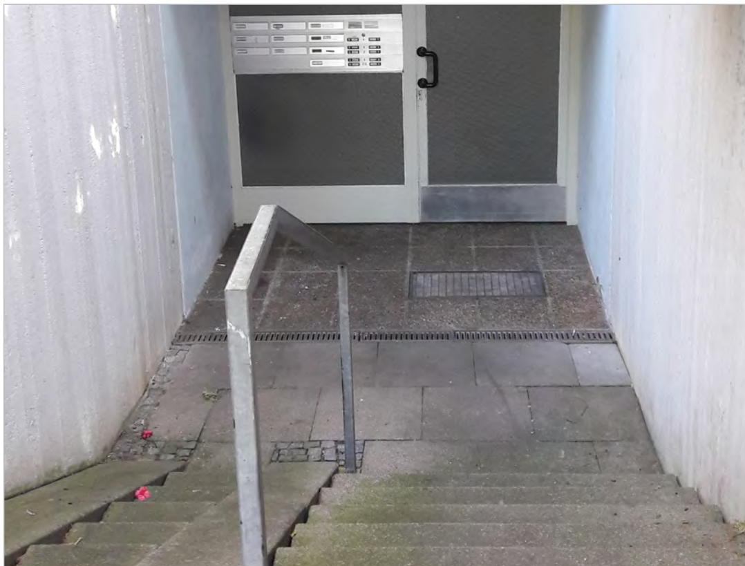
Hauseingang nicht barrierefrei (LHH)
