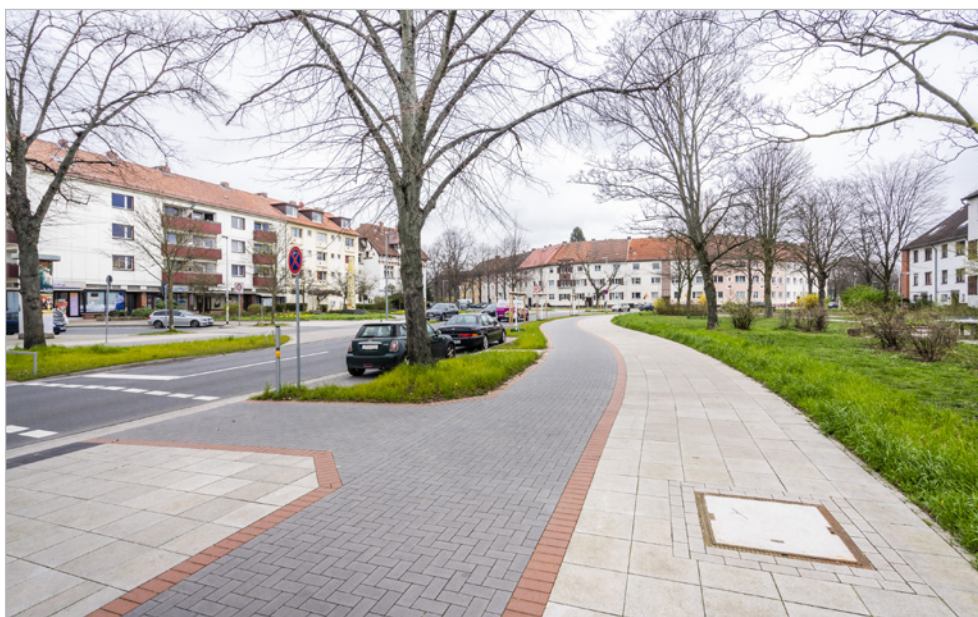
Für Fußgänger*innen und Radfahrer*innen hat sich die Aufenthaltsqualität der Fenskestraße deutlich verbessert. (LHH, Geoinformation)
