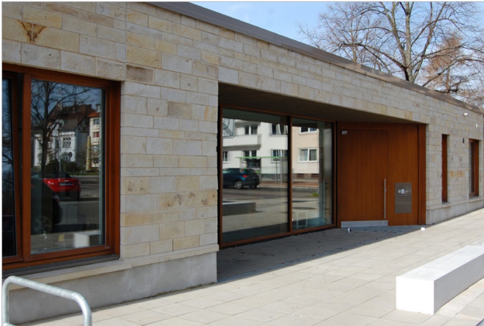
Der Eingangsbereich der neuen Kita öffnet sich zur Hüttenstraße. (LHH)
