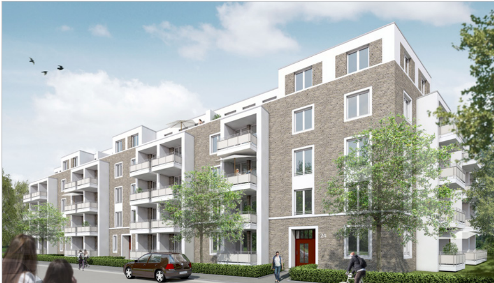
An der Ecke Hüttenstraße/Auf dem Dorn baut die Weser-Wohnbau ein neues Wohnhaus mit 63 Eigentumswohnungen. (WWB Weser-Wohnbau)
