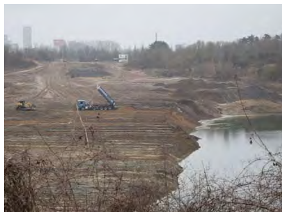
Abb. 54: Vorbereitung der HPC II Fläche zum Naherholungsraum in Misburg-Süd
