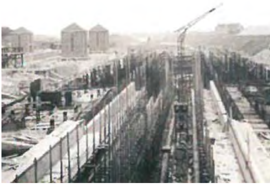
Abb. 19: Baubeginn Anderter Schleuse um 1924
