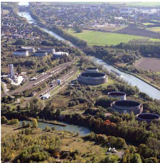
Abb. 49: Industriebrachen der ehemaligen Deurag-Nerag Raffinerie in Misburg-Süd
