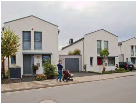
Abb. 66: Neubauquartier Steinbruchsfeld-West in Misburg-Nord
