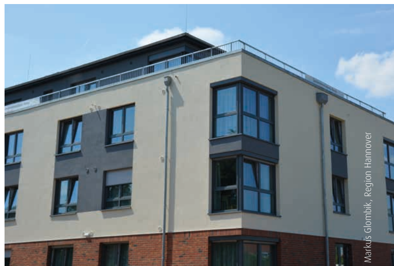
Leuchtturmprojekt: Energieeffizientes Pflegeheim in Burgdorf
