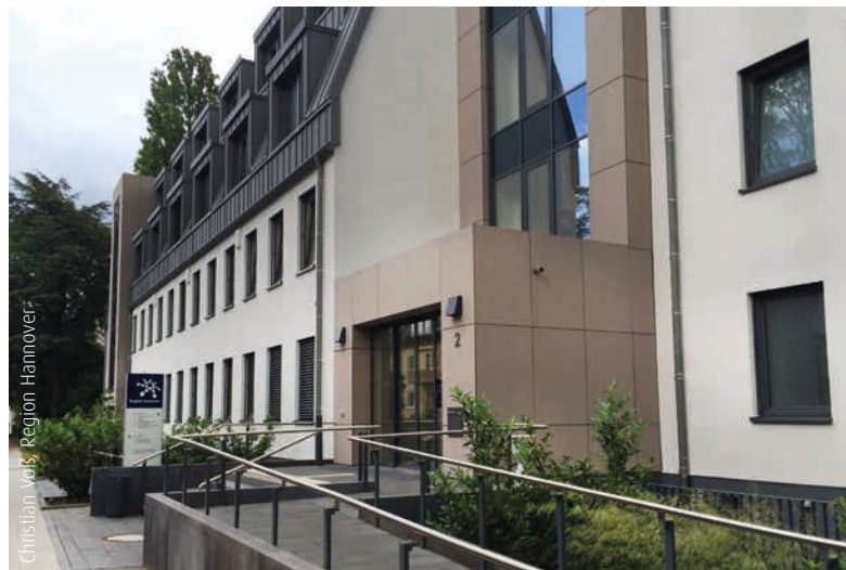
Energetische Sanierung des Gesundheitsamtes der Region Hannover in der Weinstraße
