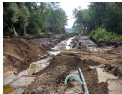
BODENSANIERUNG IM WISSENSCHAFTSPARK MARIENWERDER
