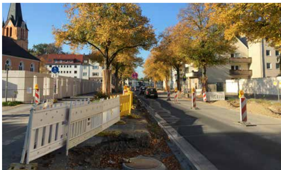
Die Bauarbeiten an der Fenskestraße sind so gut vorangekommen, dass die Straße schon früher fertiggestellt sein wird. Fotos (2): Krings
