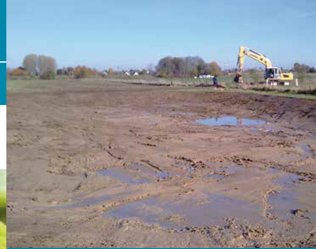
Bau des westlichen Gewässers im November 2015
