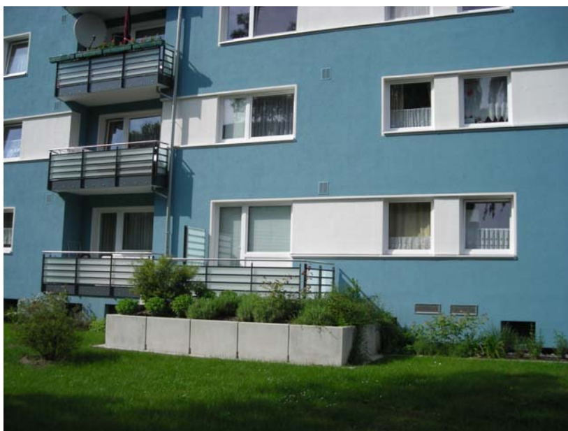
farbig abgesetzte Fensterbäder in der Weizenfeldstraße
