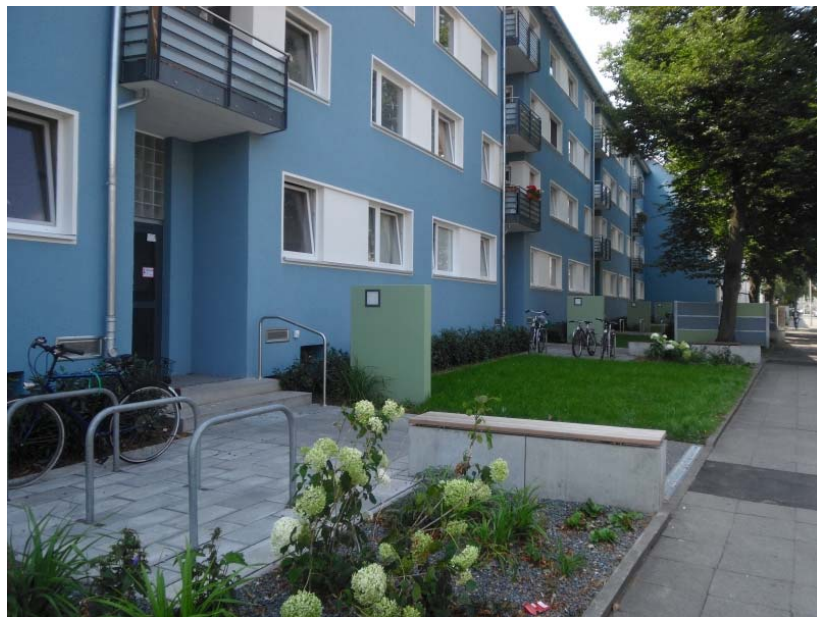
Neue Orte zum Verweilen: Sitzgelegenheiten in der Weizenfeldstraße
