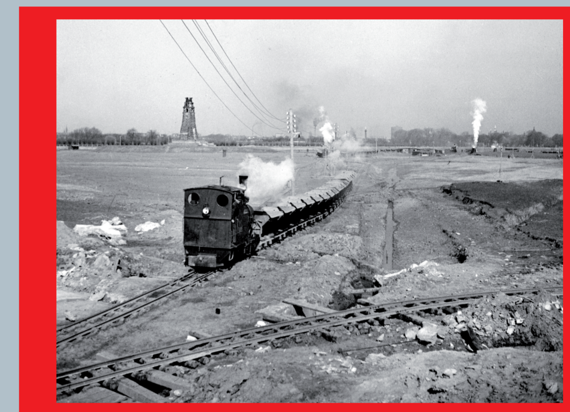
Maschsee-Arbeiten kurz vor Abbruch des Turms, Foto, ohne Datum, 1934/35
