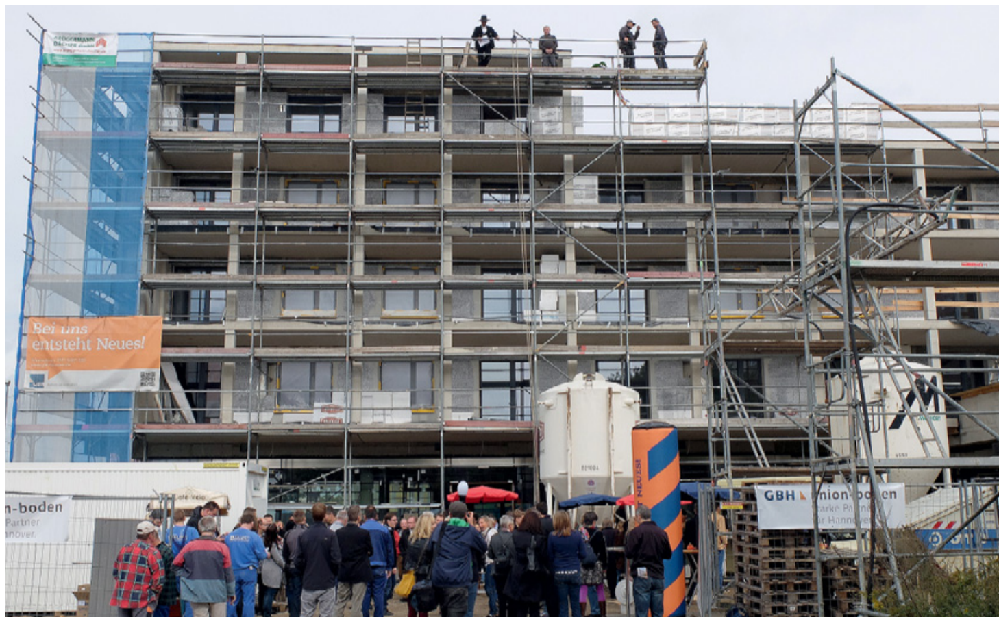
Zum Richtfest am Hainhölzer Markt kamen zahlreiche Gäste und lobten die gute Zusammenarbeit.
