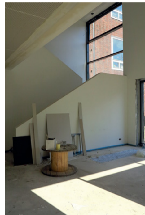
Auch im Inneren des Neubaus laufen die Arbeiten auf Hochtouren.
