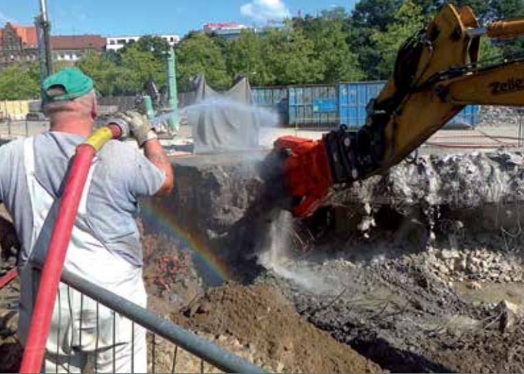
Abbruchschiere in Aktion – Minimierung der Staubemissionen mittels gezieltem Wasserstrahl
