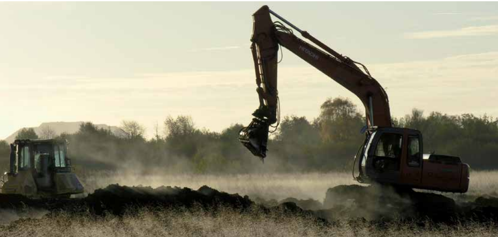
Bagger und Raupe im Einsatz für den Bau eines Amphibienschutzgewässers im NSG Meerbruchswiesen
