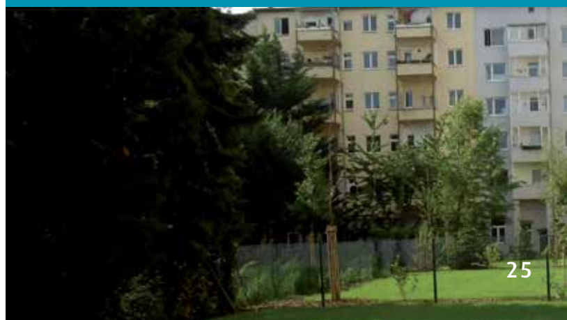
Innenhof nach der Sanierung
