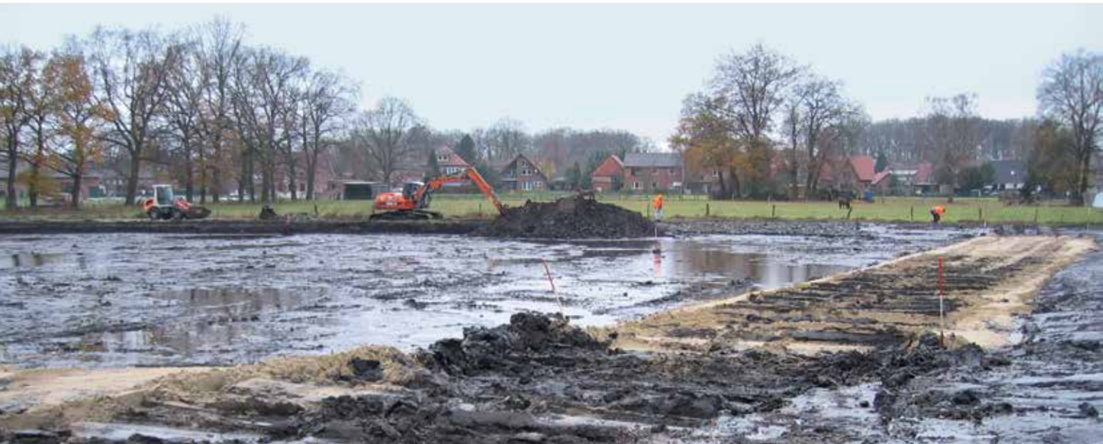
Ein Regenrückhaltebecken wird ausgebaggert
