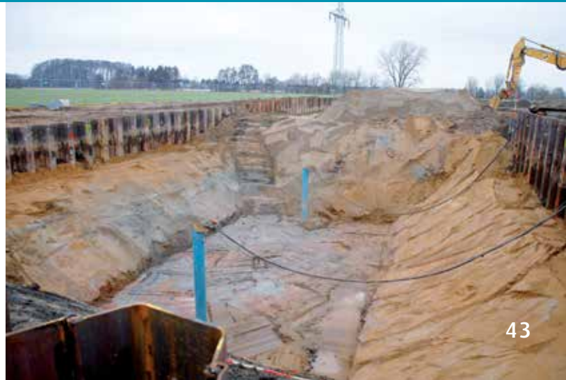
Blick in die Baugrube (Südfeld)
