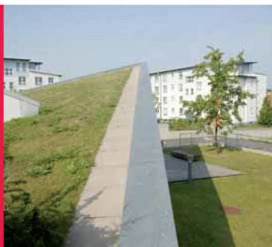
Dachbegrünung Roof greening
