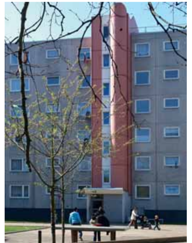
Die in die Jahre gekommenen Fassaden und Hauseingänge prägen die Wohnhöfe.
