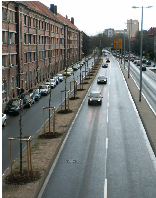
Abb. 6: Die Friedrich-Ebert Straße nach Reduzierung der Fahrbahnen; Blick nach Süden.
