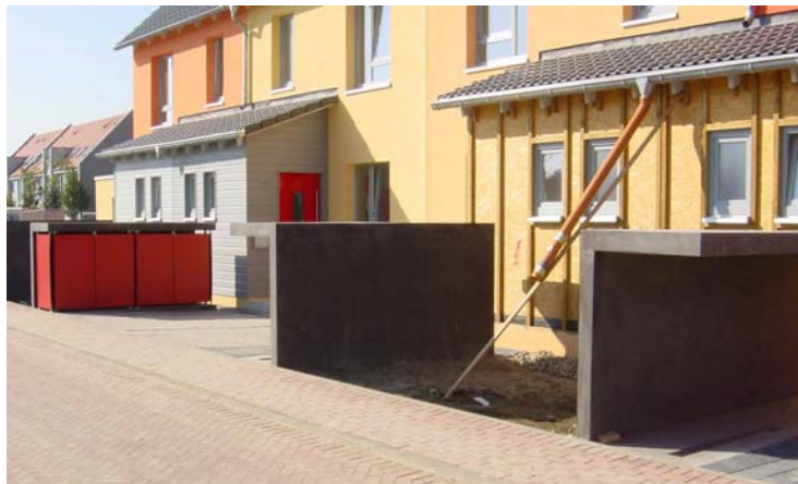
Puntos de recogida de residuos cubiertos
