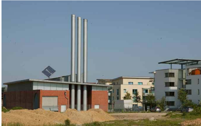
Central de calefacción
