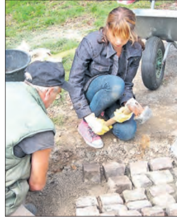
Pflasterarbeiten: Eine Schülerin mit ungewohntem Werkzeug bei Pflasterarbeiten
