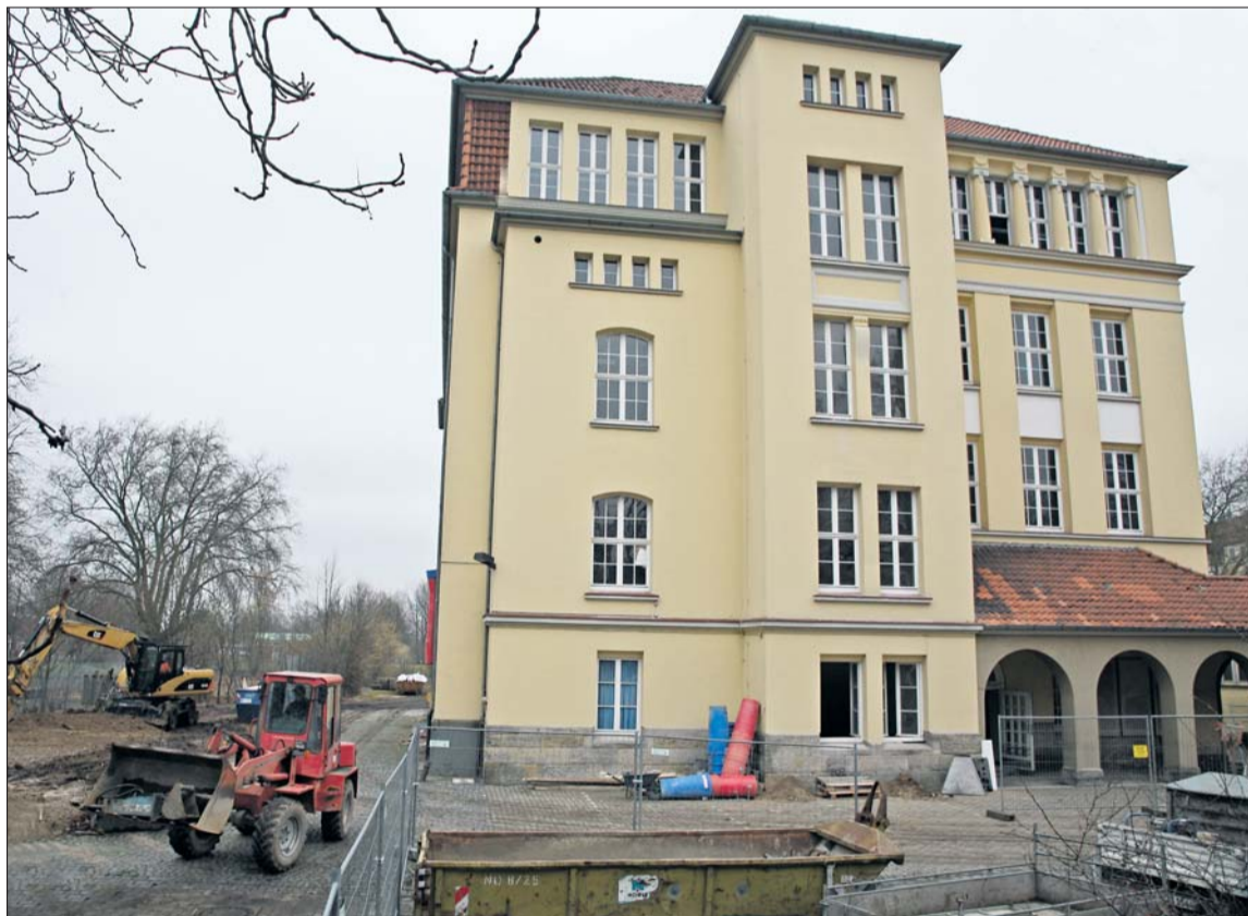
Der Umbau hat begonnen: In den nächsten Monaten wird die ehemalige Alice-Salomon-Schule in ein neues Kultur- und Bildungszentrum für Hainholz umgebaut.
