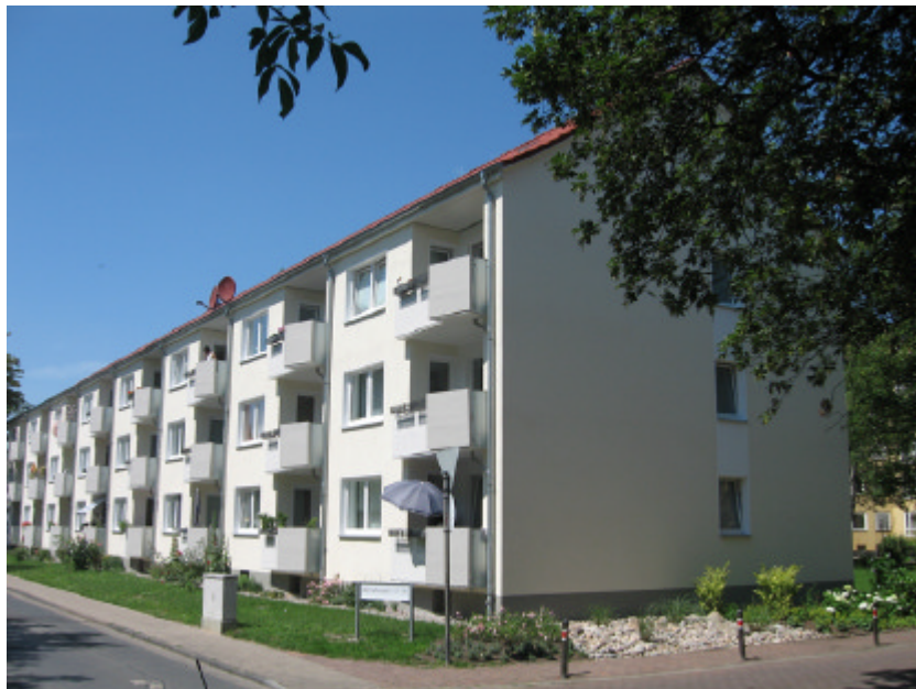
Bömelburgstraße 13-19 nach der Modernisierung
