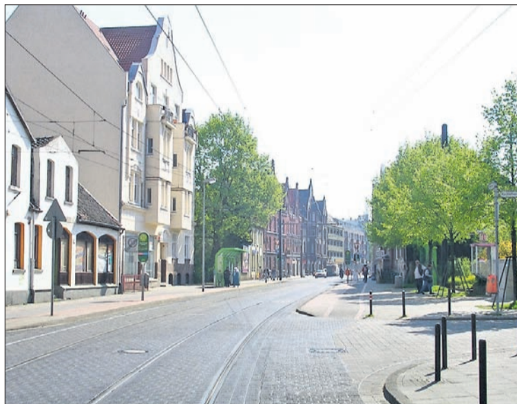
Ein Beispiel: Rund um die Harenberger Straße hat sich durch die Sanierung viel getan.
