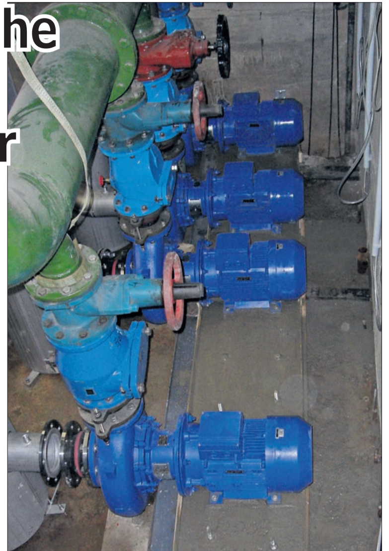
Die neuen Umwälzpumpen im Volksbad Limmer helfen Energie zu sparen und leisten somit einen Beitrag zum Umweltschutz.
