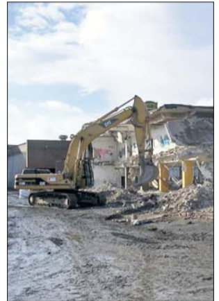
Erste Teile wurden bereits abgerissen.
