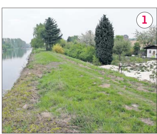
Unterhalb der Wasserlinie
