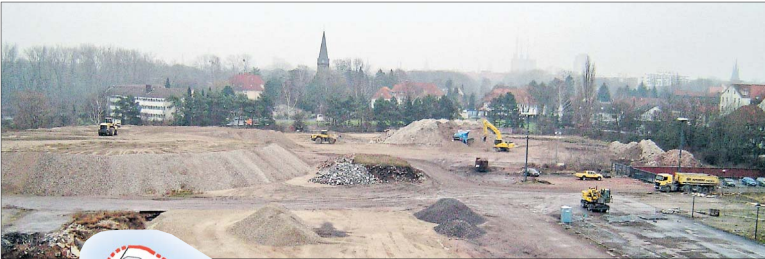
Reges Treiben: Der hier zwischengelagerte Boden ist für eine spätere Verwendung auf dem Wasserstadt-Gelände vorgesehen. Foto: Steffen Muth
