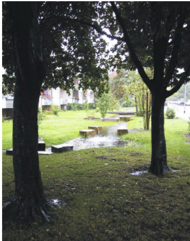
Freiflächengestaltung mit Regenwasserversickerung
