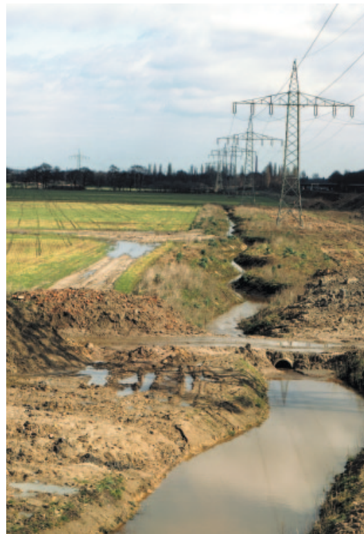
Bild 21: Provisorischer Graben, parallel zur A2
