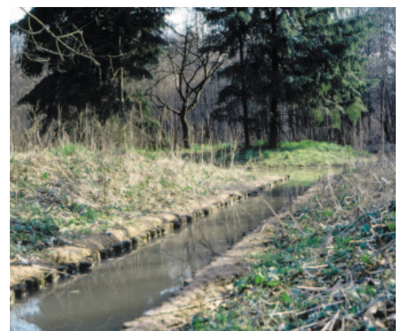
Bild 24: Verbindungsgraben zwischen den Einzelbecken – Böschungen flach geneigt – naturnaher Verbau mit Kokosswalzen und Rundhölzern
