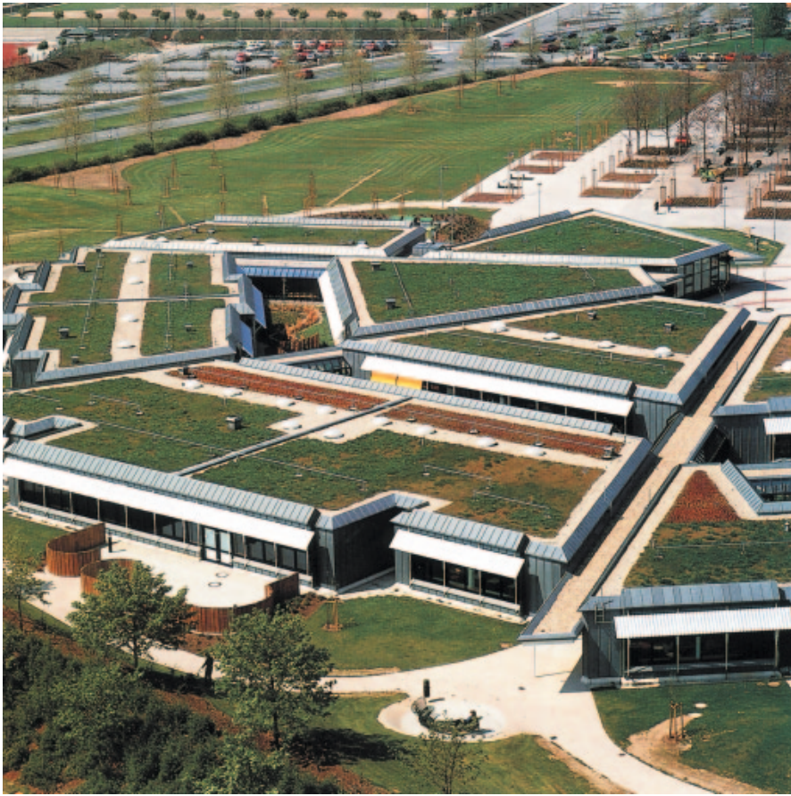
Bild 2: Ausführungsbeispiel Dachbegrünung bei gewerblich genutz- ten Gebäuden (Foto: vvd)
