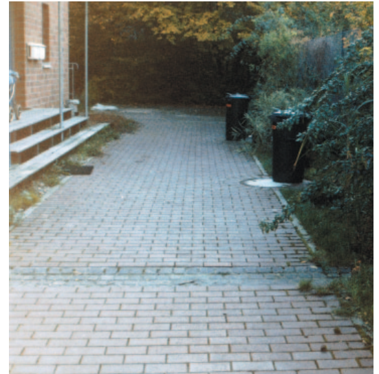
Bild 4: Offene Ableitungsrinne und Mulde
