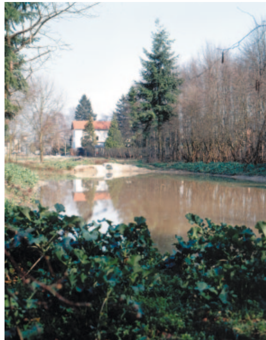
Bild 23: Regenrückhaltebecken Seelhorst Einlaufbereich mit Absetzbecken
