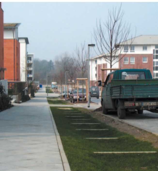
Bild 3: Vorhalten von Versickerungsflächen – hier Mulden-Rigolen-Elemente am Kronsberg
