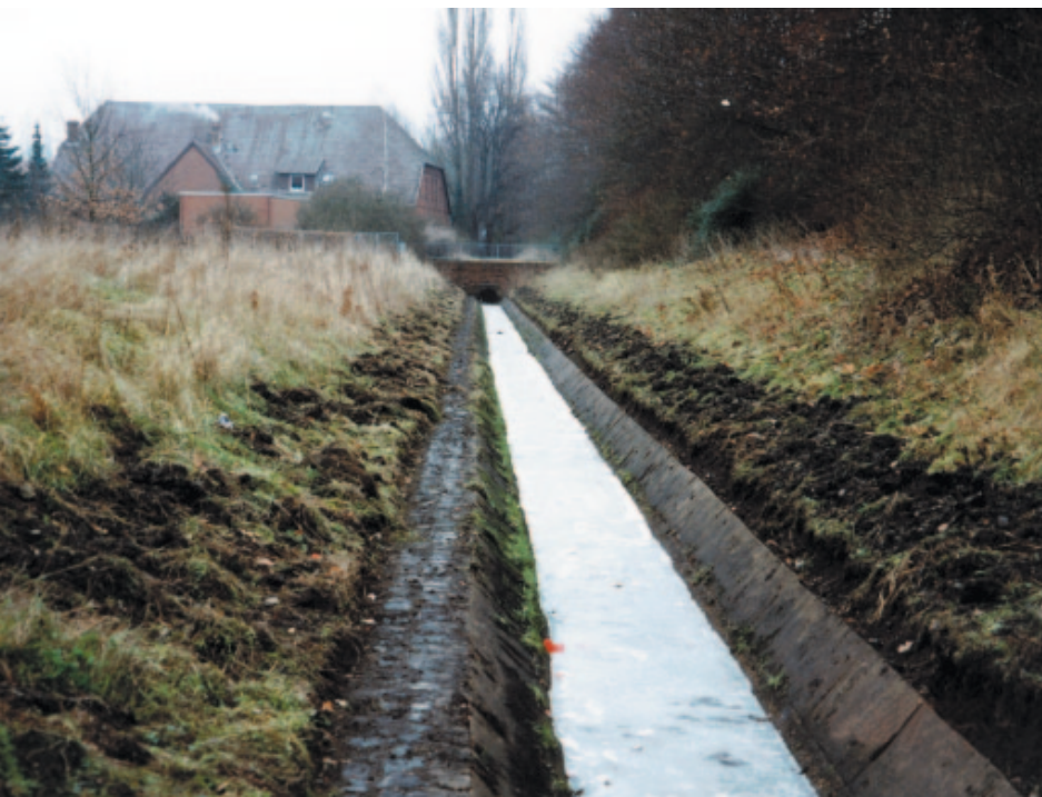
Bild 8: Schiffgraben (Entfernung von Betonschalen)
