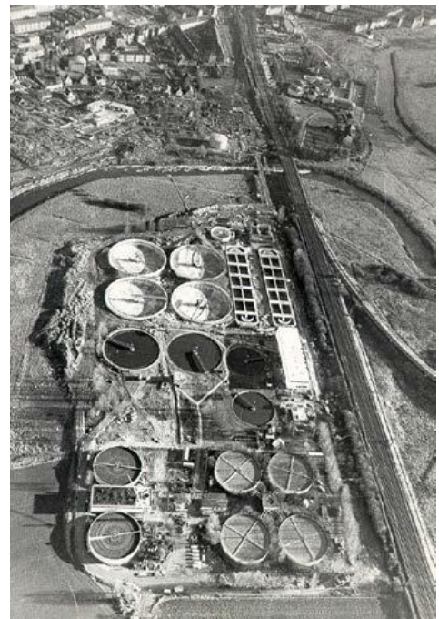
Klärwerk Herrenhausen: Ausbau der biologischen Anlage um 1972
