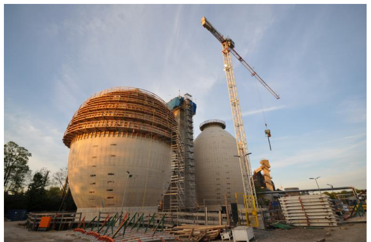
Blick auf die neuen Faultürme
