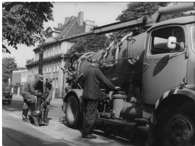
Kanalarbeiter des Stadtentwässerungsamtes
