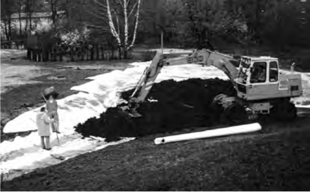
Foto 6-1: Beispiel einer Sanierungsmaßnahme
